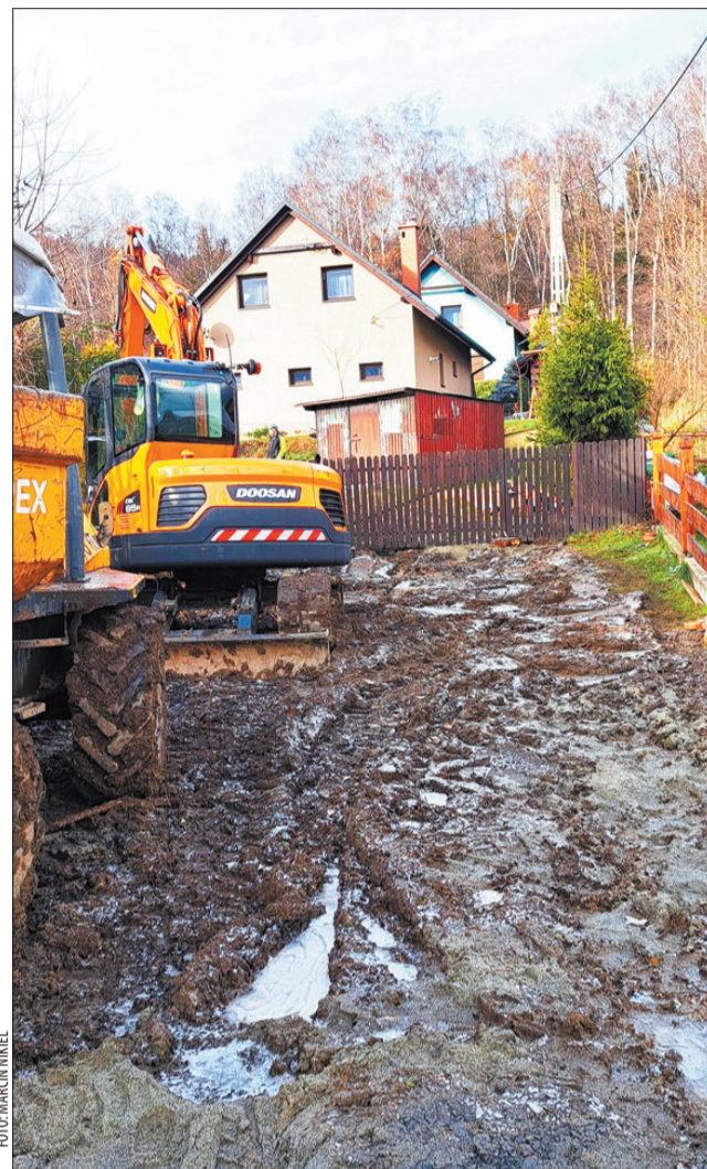
Przy ulicy Skośnej w Mesznej prowadzone są obecnie jeszcze prace w ramach dodatkowego Zadania nr 15.
