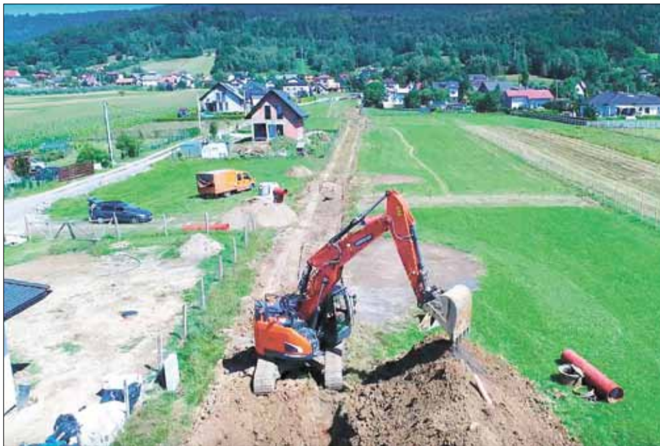
Inwestycja budowy kanalizacji w Wilkowicach prowadzona była na szeroką skalę w rejonie ulicy Galicyjskiej już w minionym roku. Niebawem rozpocznie się tu kolejny ważny etap inwestycji, a więc montaż pompowni ścieków.
