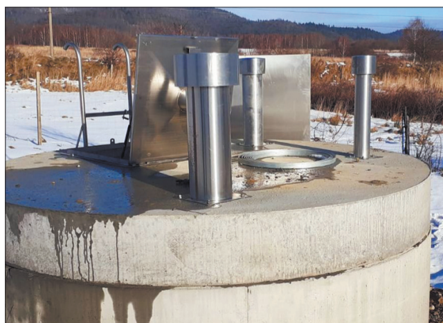
Dwie funkcjonalne tłocznie ścieków zamontowane zostały w Wilkowicach. Ta przy ulicy Chabrowej jest już w trakcie rozruchu technologicznego, który przebiega bez zakłóceń.
