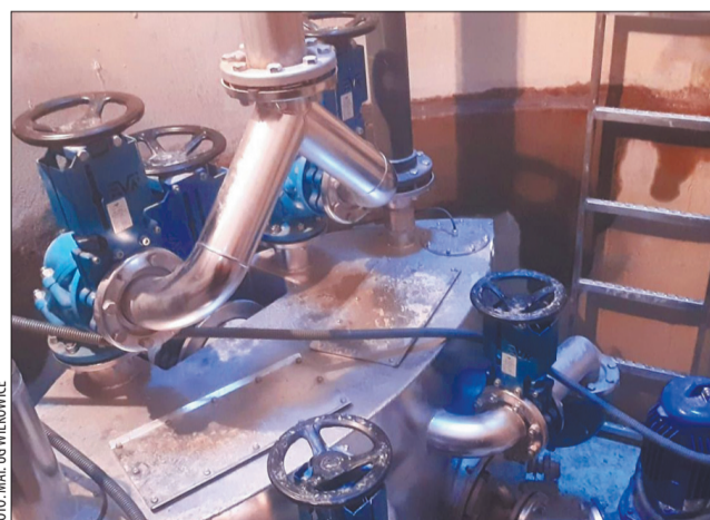
Dwie funkcjonalne tłocznie ścieków zamontowane zostały w Wilkowicach. Ta przy ulicy Chabrowej jest już w trakcie rozruchu technologicznego, który przebiega bez zakłóceń.
