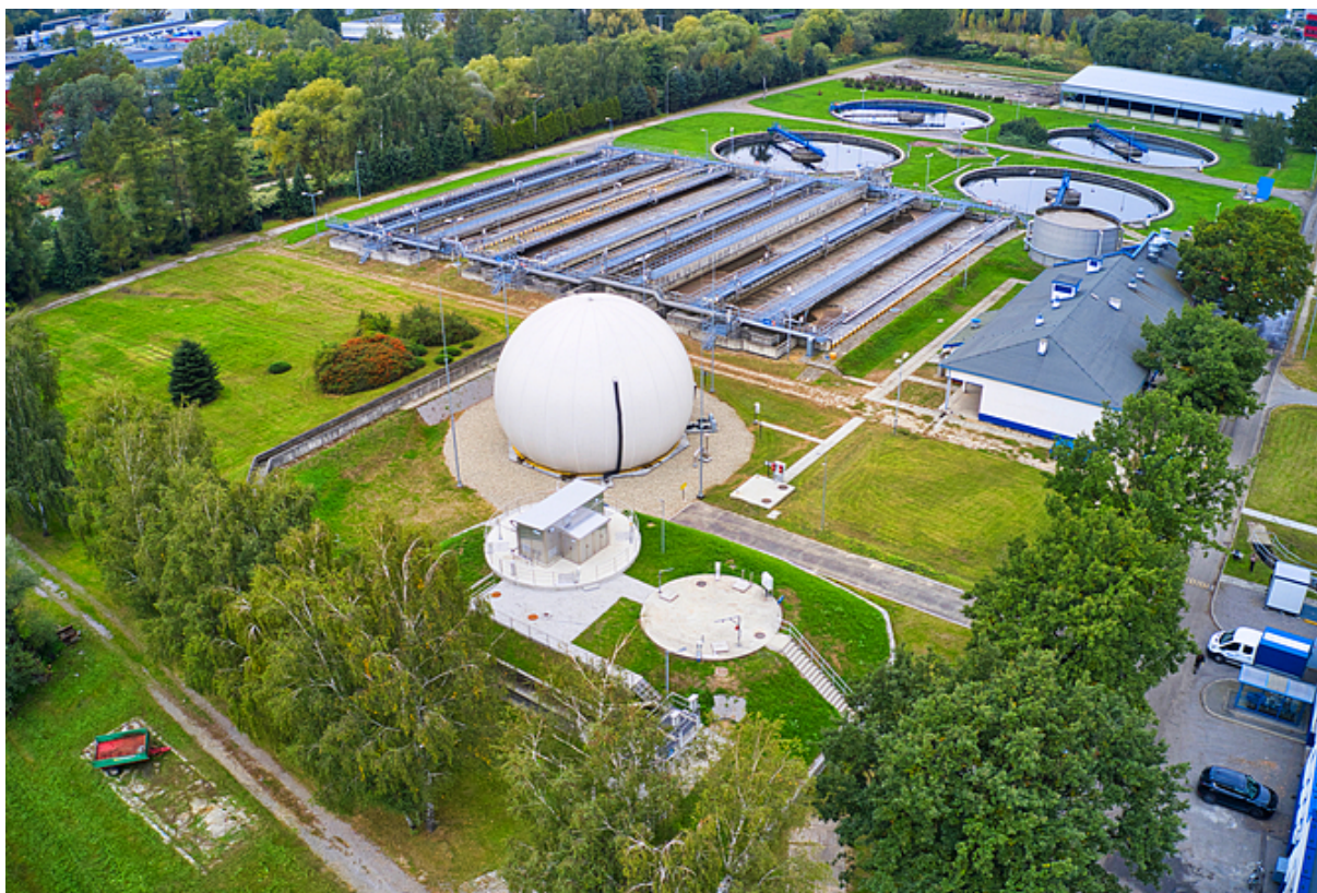
Rysunek 22. Oczyszczalnia ścieków w Komorowicach
