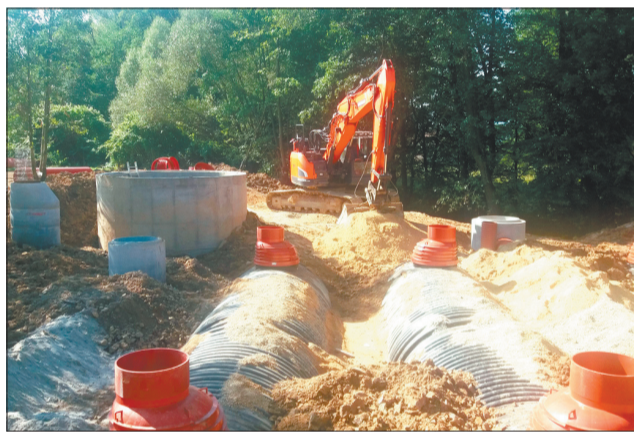
Najważniejszym elementem inwestycji w mijającym roku była budowa sieciowych pompowni ścieków w dwóch lokalizacjach w Wilkowicach. Roboty ziemne objęły m.in. wykonanie skomplikowanych głębokich wykopów.
