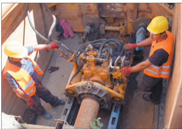
Przewierty pozwalają uniknąć kosztownego rozkopania zagospodarowanych terenów, np. obok hali sportowej.
