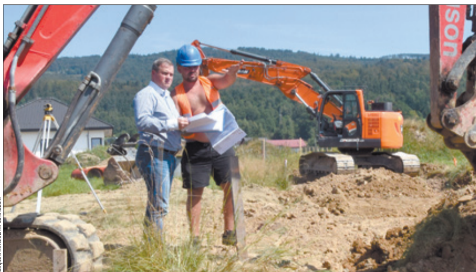
Na Huciskach trwają prace budowlane doprowadzające sieć do przyszłej przepompowni.
