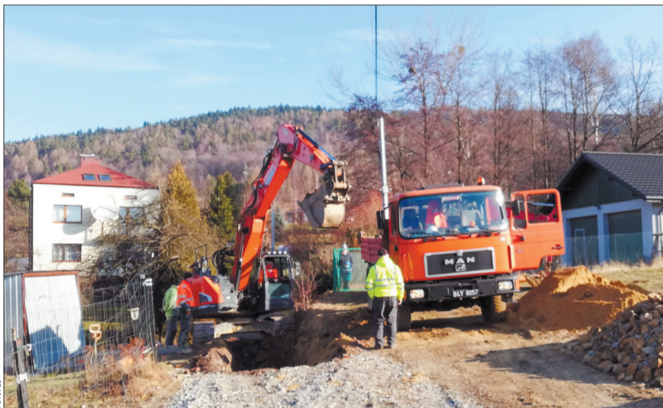
Zaawansowane prace związane z budową sieci kanalizacji sanitarnej prowadzono w ostatnich tygodniach m.in. przy ulicy Malinowej w Wilkowicach.
