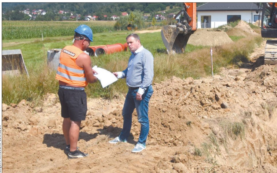
W toku zaawansowanych prac związanych z budową sieci kanalizacyjnej wójt Janusz Zemanek nadzorował zwłaszcza te miejsca, gdzie front robót wymagał dokonywania istotnych uzgodnień.
