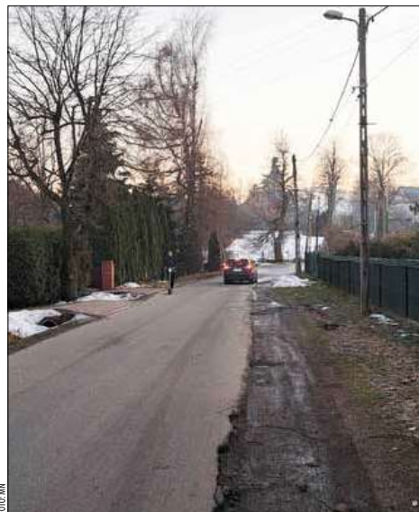
Ul. Do Lasku w Wilkowicach doczeka się w przyszłym roku remontu, który obejmie nie tylko jej nawierzchnię, ale i wykonanie chodnika poprawiającego bezpieczeństwo.
